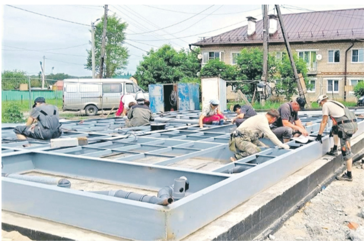
Котельная в Губастове обеспечит теплом порядка 600 человек.
