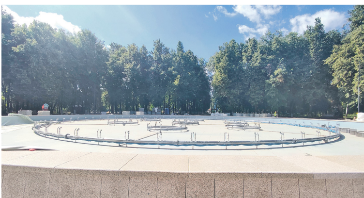
Строительство фонтана завершено. Он обещает стать одним из самых красивых в Московской области.
