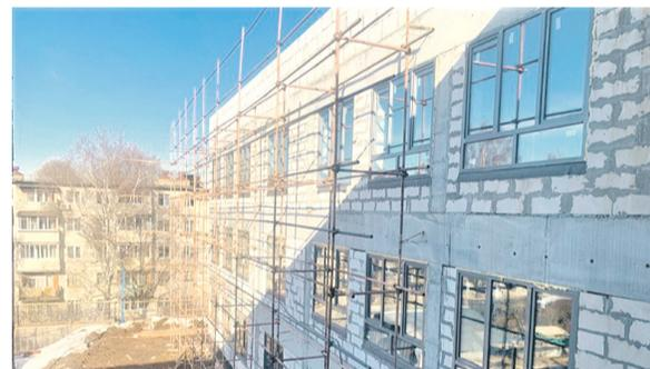
В Коломне продолжается возведение пристройки к гимназии № 8 на улице Леваневского. Строительная готовность объекта в настоящее время составляет более 50%. Сейчас на объекте трудятся более 80 рабочих. Строители приступили к монтажу вентилируемого фасада. Ведутся работы по устройству внутренних перегородок и инженерных сетей, а также по установке оконных блоков.
