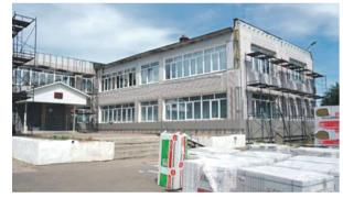
По периметру здания установили леса, специалисты проводят обшивку фасада, кладут утеплитель и керамогранитную плитку. По словам представителя подрядчика, многослойная «шуба», совокупная толщина которой составляет более 100 мм, и современные изоляционные материалы помогут значительно снизить теплопотери, и в классах будет комфортная температура в любую погоду.
