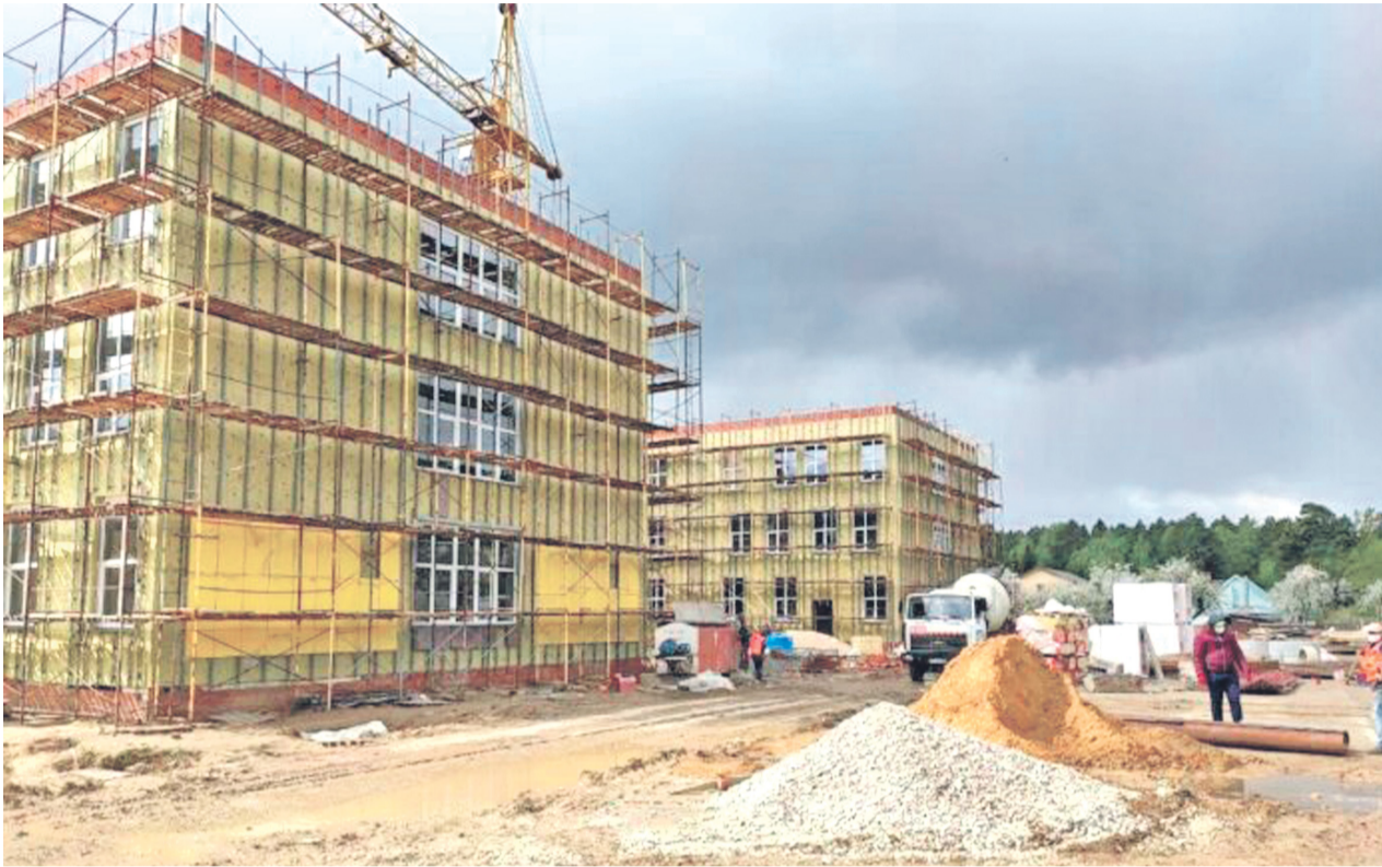
В ПОСЕЛКЕ ПЕСКИ возводится новый корпус школы на 500 мест.
