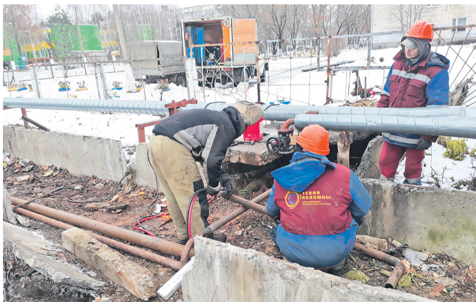
РАБОТЫ в системе водоснабжения Соснового Бора уже ведутся.
