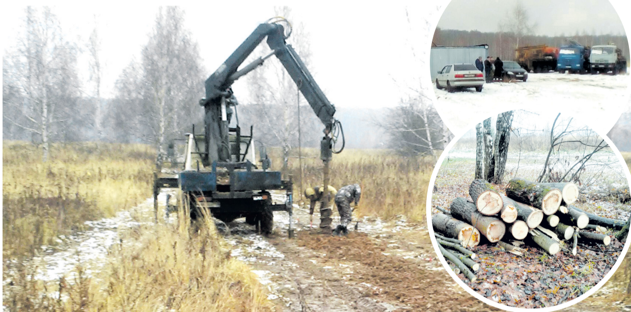
НА ФОТО видно, как поле в деревне Свистягино превращается в строительную площадку
