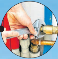
Осмотр и содержание общедомовых коммуникаций
