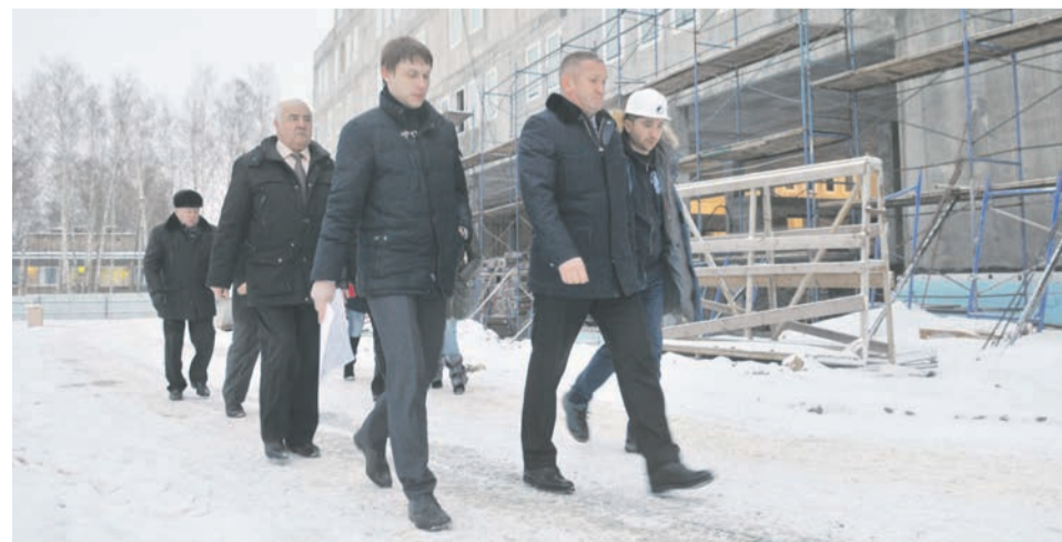
ВИЗИТ. В декабре 2015 года на стройплощадку перинатального центра приезжал зампред Правительства МО Герман Елянюшкин.
