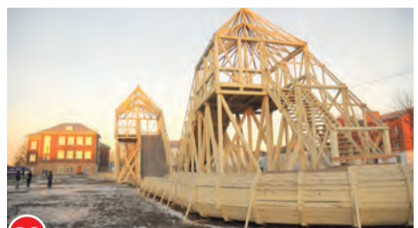
20 У горок на Житной площади: прямо под деревянным настилом, который расположен со стороны исторического здания.
