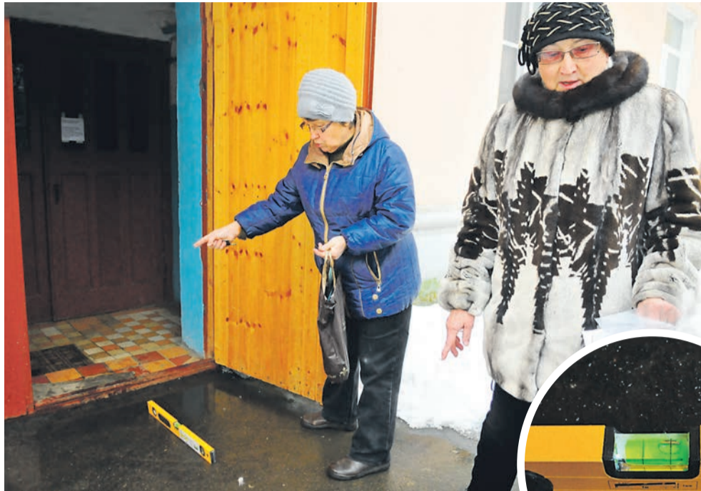
УКЛОН. Жительница дома с помощью уровня демонстрирует, что асфальт у их подъезда уложен под уклон.
